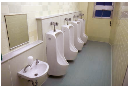
改修された男子トイレ
