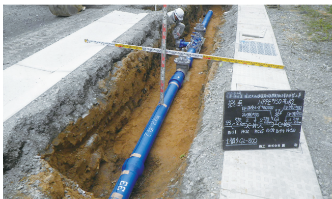
布設替え工事
