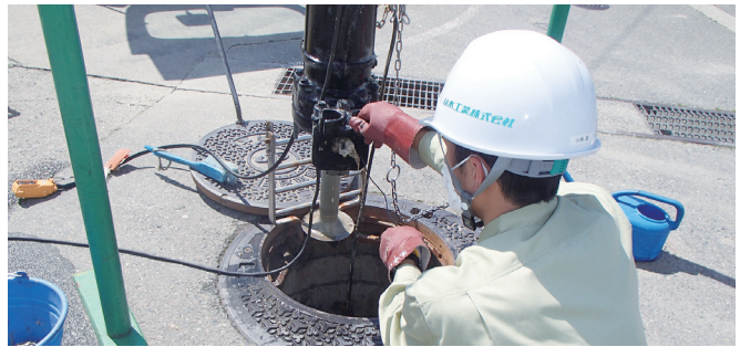
ポンプに詰まったタオルを取り除く作業
