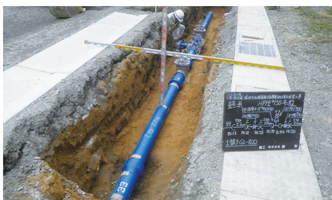
布設替え工事
