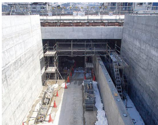
JRアンダーパス工事
