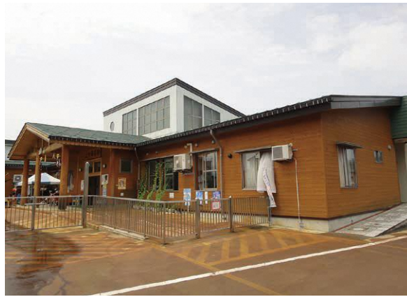
上町保育園（エアコン整備予定）
