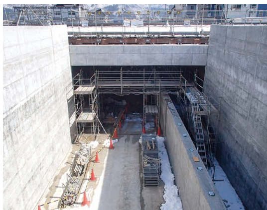
JRアンダーパス工事
