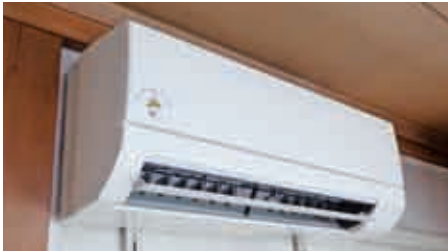
エアコンを整備
