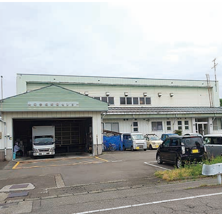
大和学校給食センター
