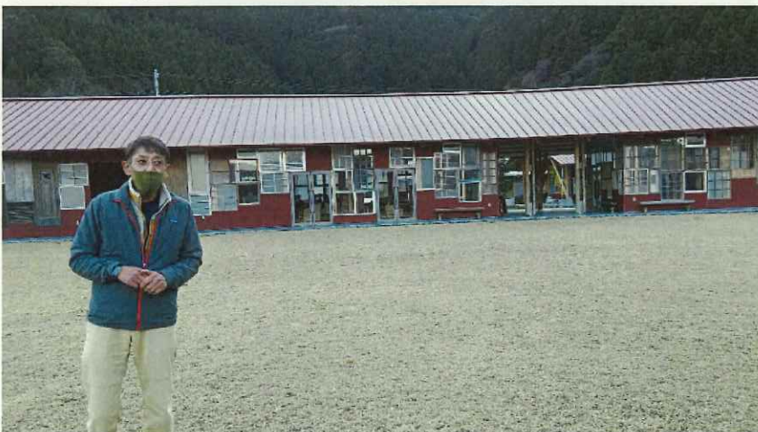
(徳島県上勝町リサイクルセンター)
