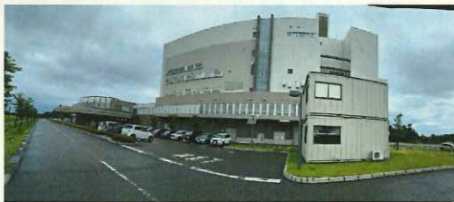
写真上：上越市クリーンセンター
