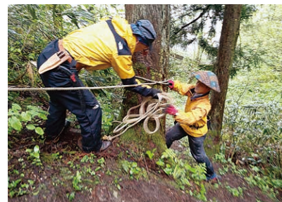
ロープ張りの様子
