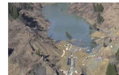
崩壊した土砂による河道閉塞
