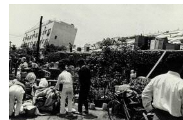
液状化により傾いたアパート
