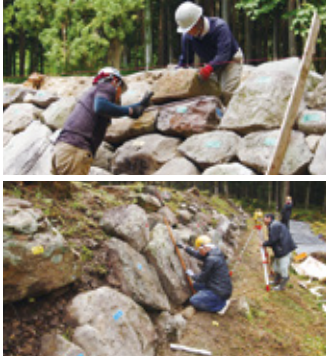
石垣の修復工事
