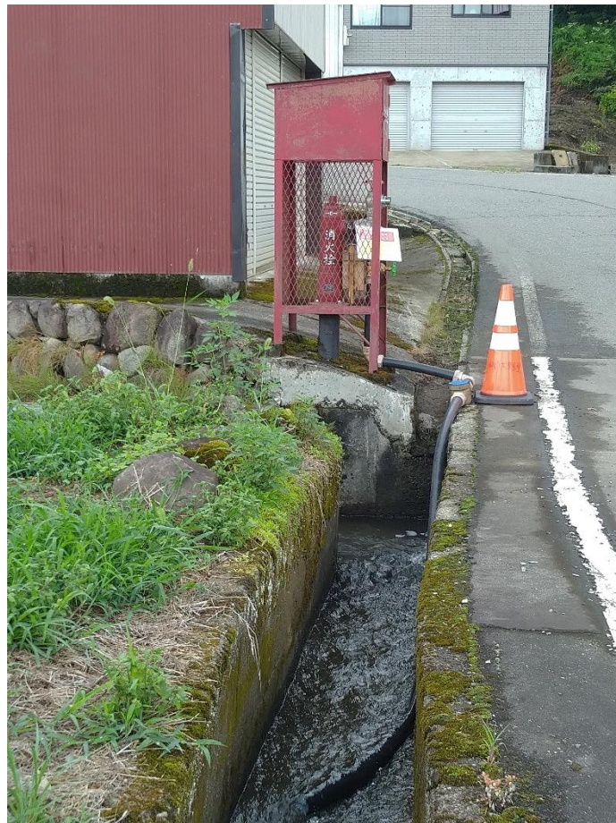
消火栓を活用した農業用水補水
