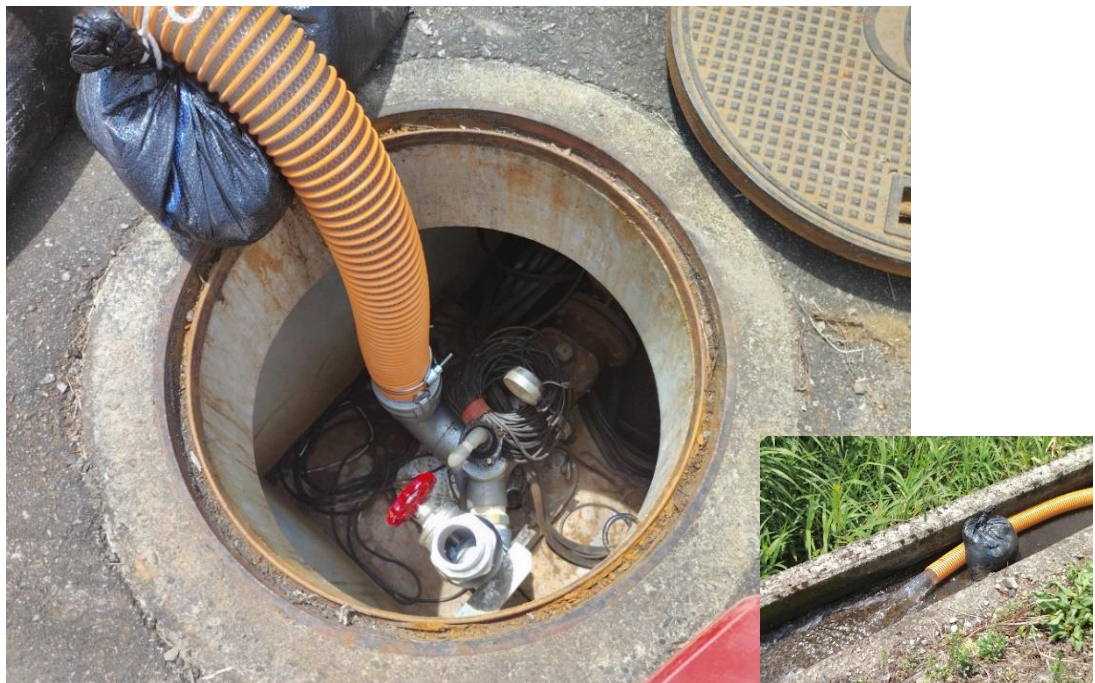
消雪井戸へのバルブベント設置
