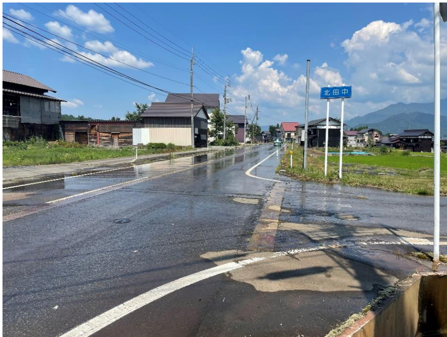
消雪パイプによる農業用水の補水補助
