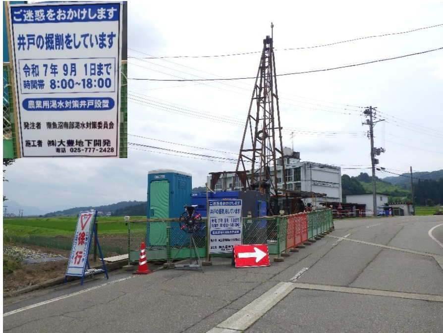
農業用渇水対策井戸掘削工事補助
