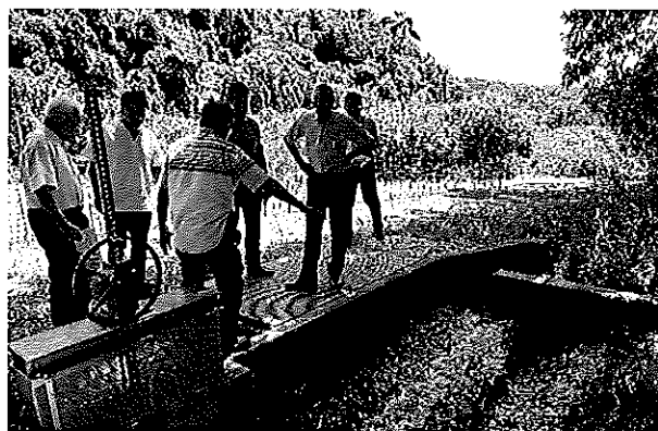
水路の途中にある分岐点「ヘッドタンク」では、落ち葉などのゴミを流水の力で取り除く構造
