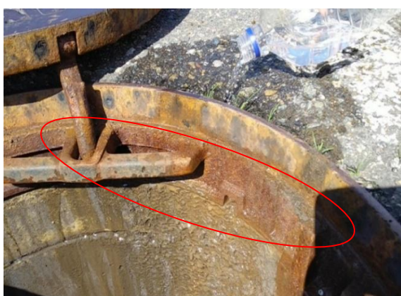
【マンホールからの浸水状況（県道落合六日町線）】
