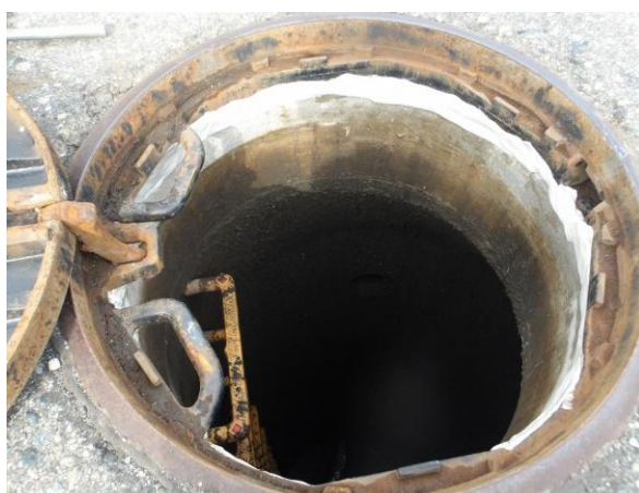
【エポキシ系樹脂接着剤の貼り付け完了】
