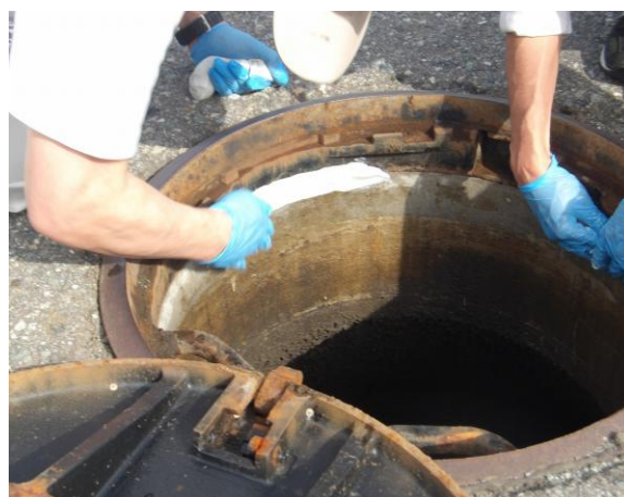
【エポキシ系樹脂接着剤の貼り付け状況】
