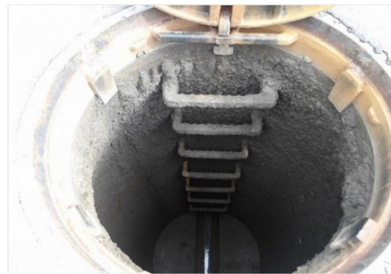
[一般県道沢口塩沢線：中野地内]
