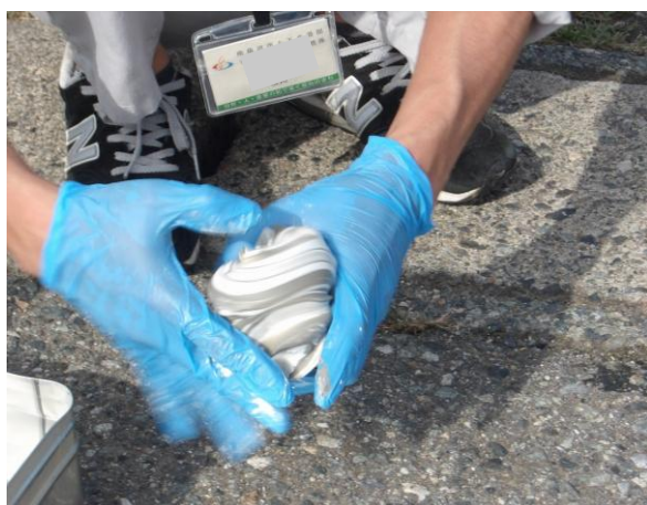
【エポキシ系樹脂接着剤の二液混合状況】
