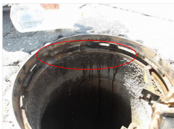
【マンホールからの浸水状況（県道落合六日町線）】
