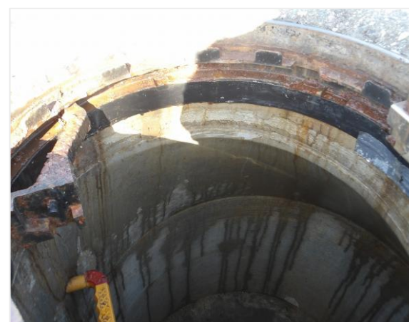
【ブチルゴム止水テープの貼り付け完了】
