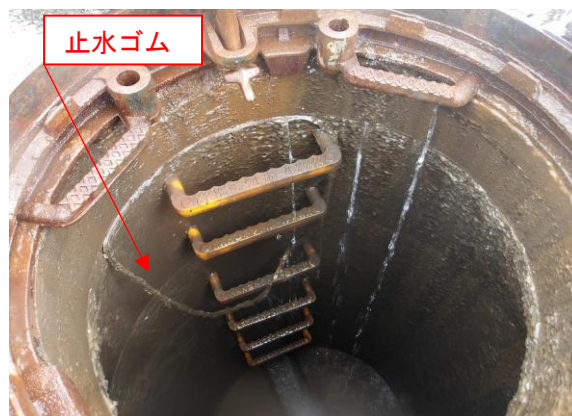
【止水ゴムの剥がれと継ぎ目からの浸入水】
