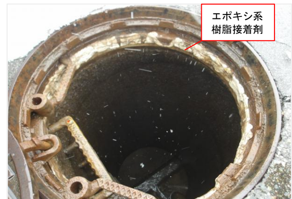
【マンホール内部の状況（MH①）】
