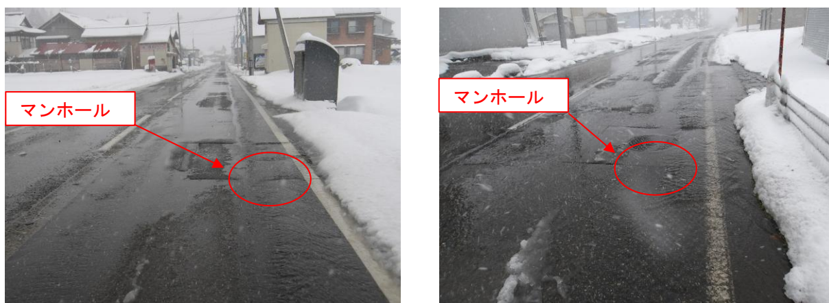
【消雪パイプの散水に伴う表流水の状況】
