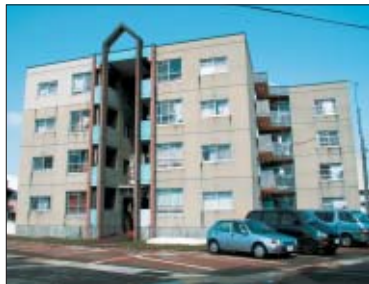
公営住宅 Municipal Housing
