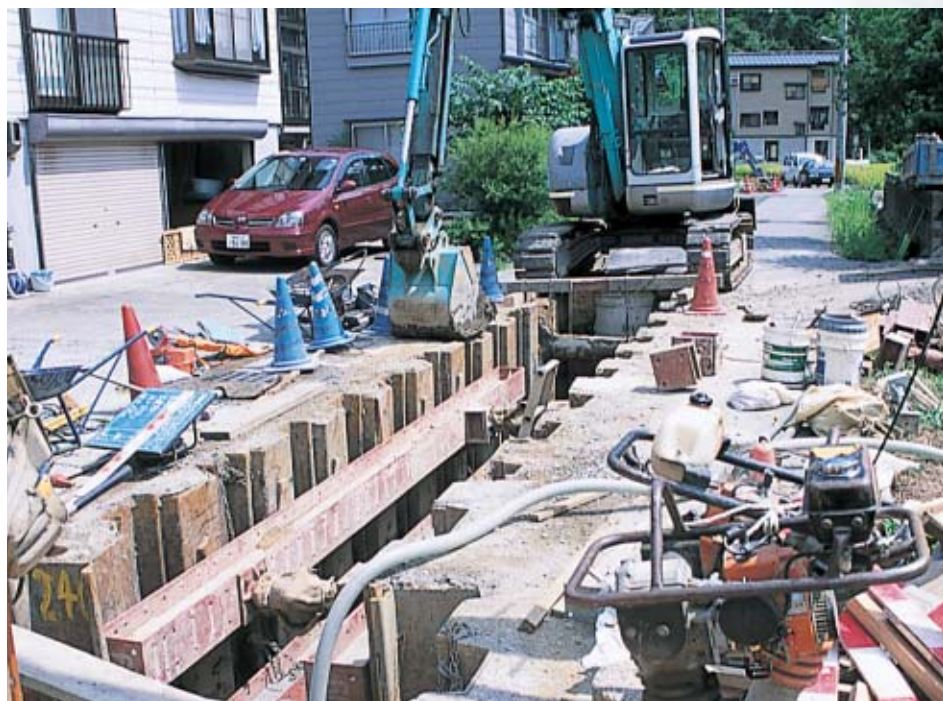
下水道の整備 Sewer Improvement Project
