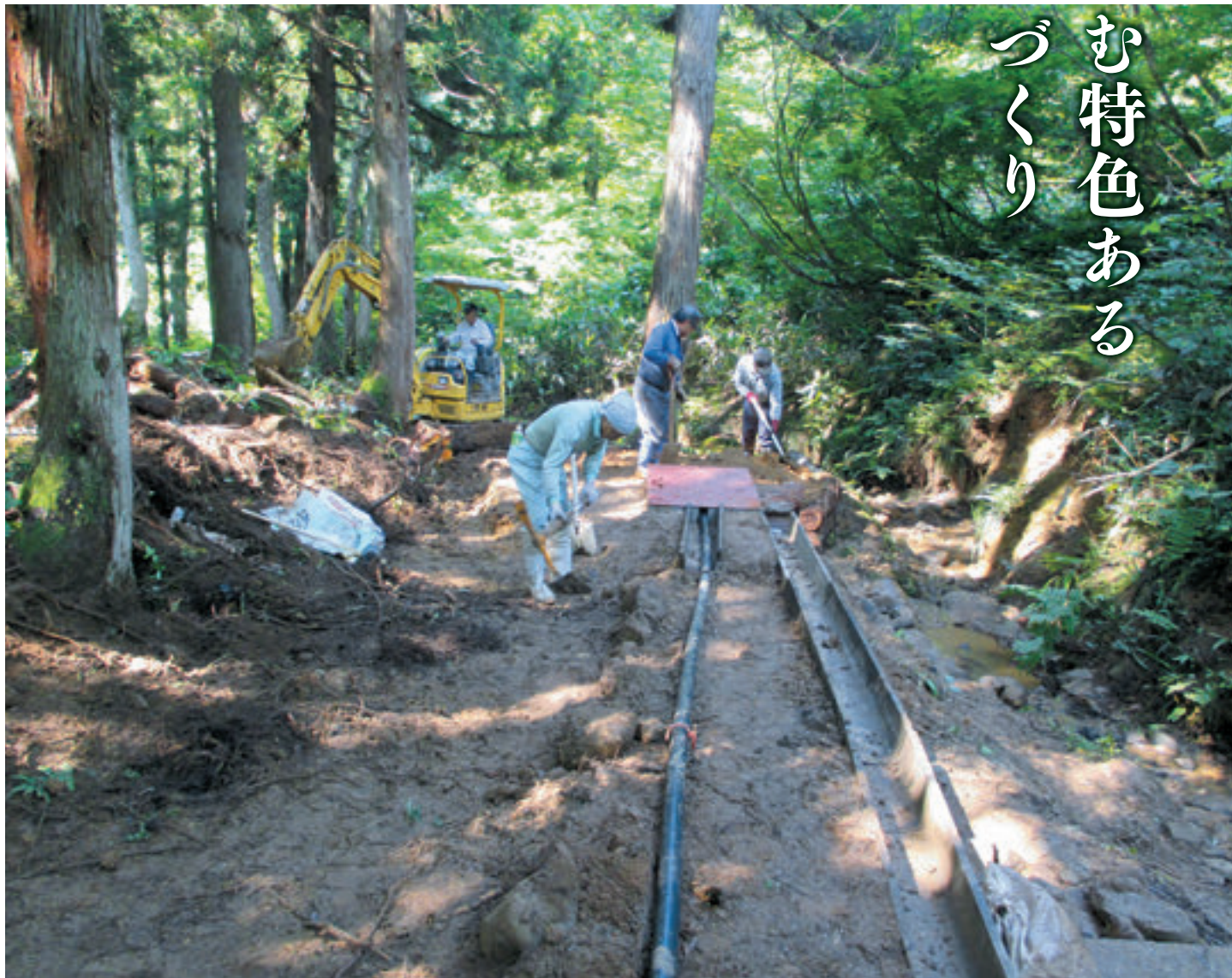
地域資源の維持(簡易水道の補修)
