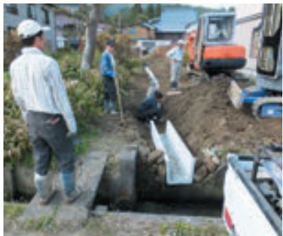
共同作業(U字溝設置)
