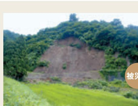
中越 大震災によって、四十日地区では山の法面が崩壊し、土砂が市道西枯木又線と一級河川四十日川を埋め、対岸のは場にまで流れ込みました。測量や応急復旧工事をしているころは、まだ余震が続き、危険と隣り合わせの作業でした。2年続きの豪雪の影響もあり、復旧には時間を要しましたが、今では市道を安全に通行することができます。
