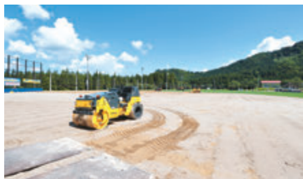
多目的グラウンドの改修状況
