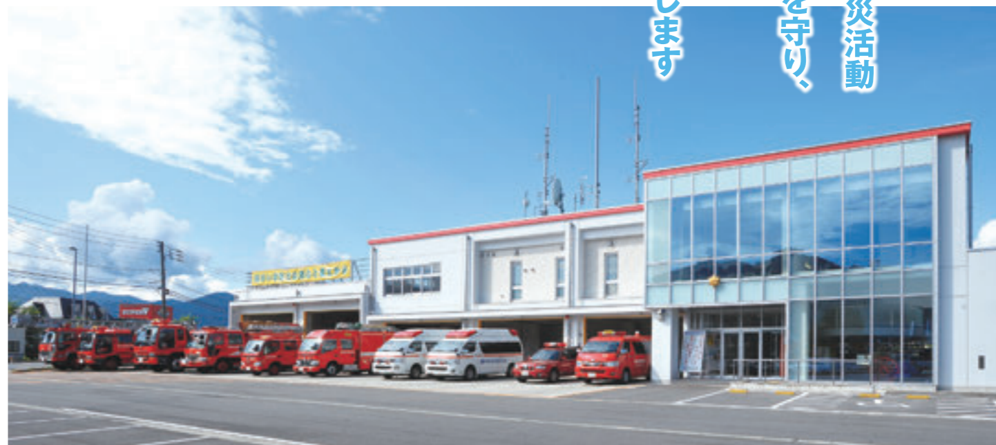
平成24年7月に消防新庁舎が完成
