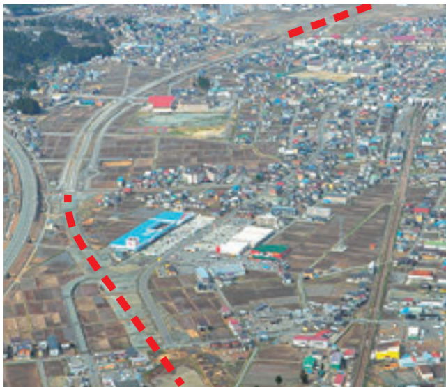
国道17号六日町バイパス (全長5.1km、現在1.3kmが暫定2車線供用中。赤破線部分は、計画・工事中)
