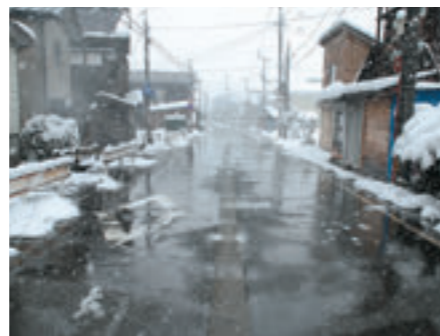
地下水を利用した消雪パイプ
