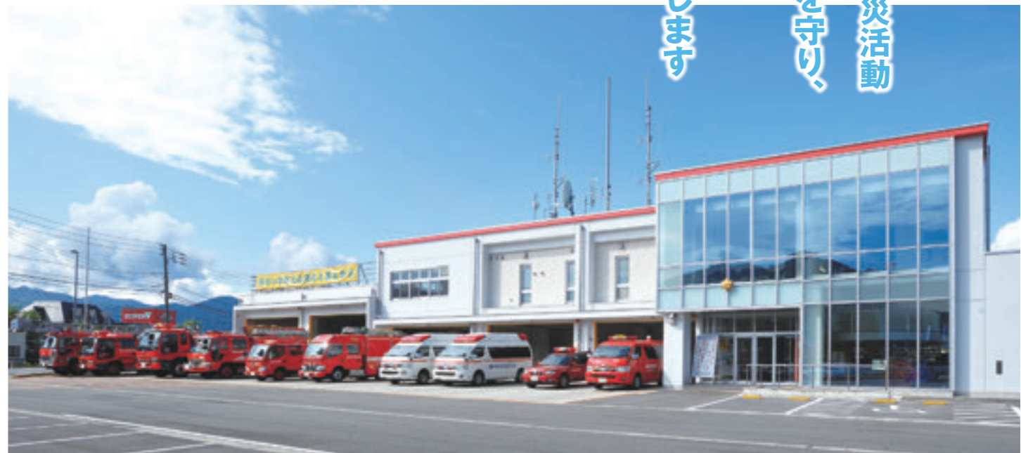
平成24年7月に消防新庁舎が完成
