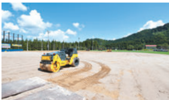
多目的グラウンドの改修状況
