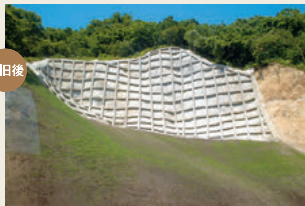
市道西枯又線 法面の復旧状況(四十日地区)
