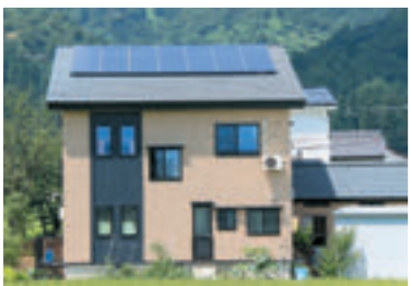
自然エネルギーを推進 太陽光発電システム設置に対し、補助金を交付しています。
