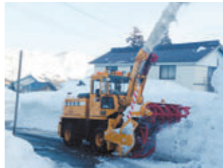
除雪車による道路除雪作業
