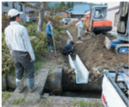
共同作業(U字溝設置)
