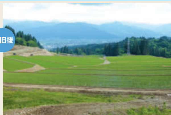
水田の復旧状況(吉里 外谷地区)
