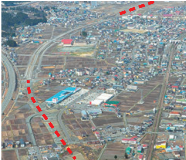
国道17号六日町バイパス (全長5.1km、現在1.3kmが暫定2車線供用中。赤破線部分は、計画・工事中)
