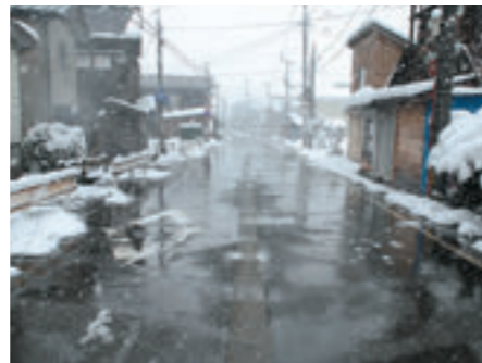
地下水を利用した消雪パイプ
