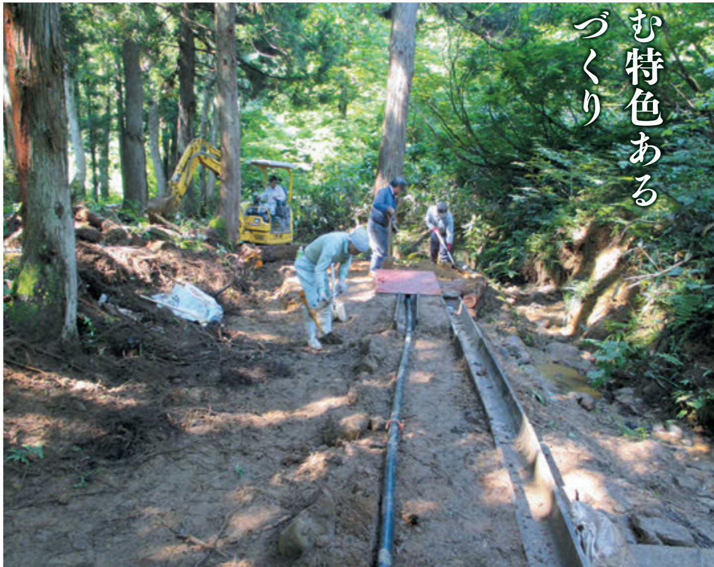
地域資源の維持(簡易水道の補修)
