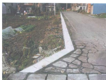
道路側溝蓋設置
