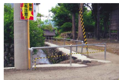
柵設置等安全対策
